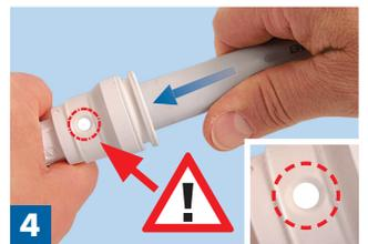
**4** Kontrollieren – wenn das Rohr richtig im Fitting sitzt, wird das Kontrollfenster im Fitting weiß.
